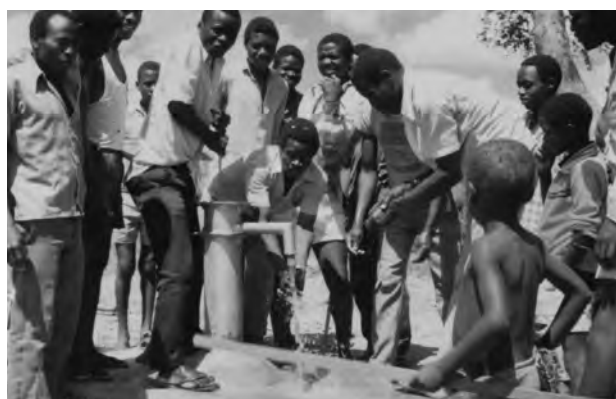
4 bornes-fontaines comme celle-ci sont à installer
